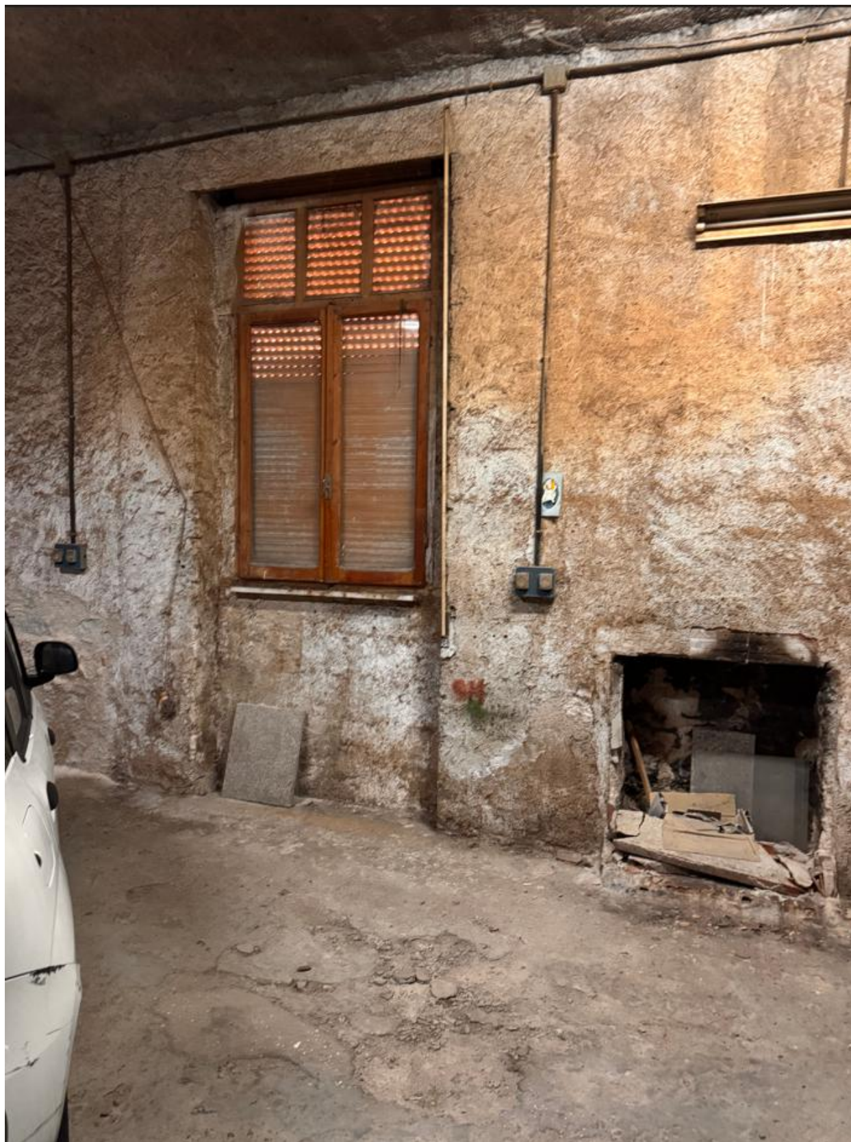
Foto 23: finestra nel garage lato nord
