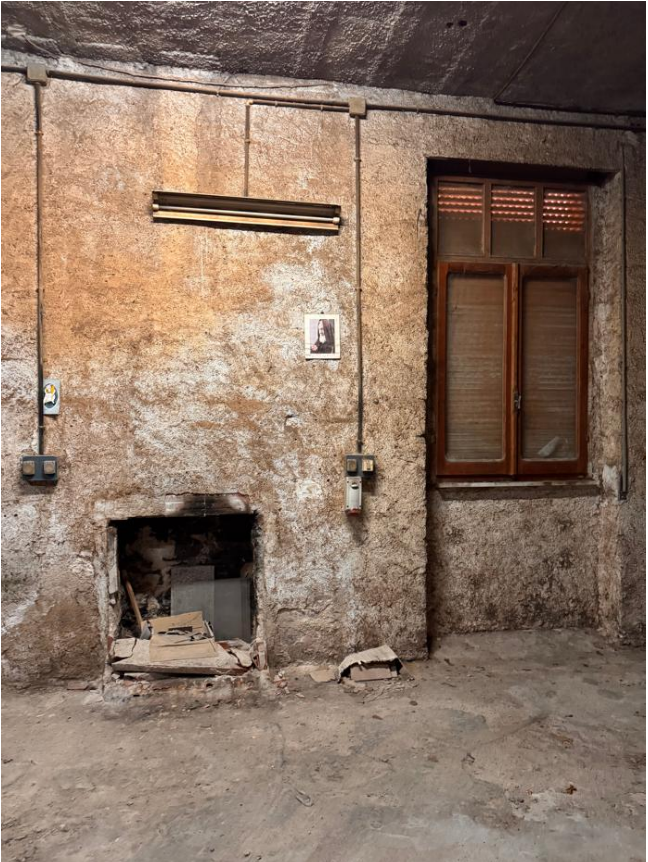
Foto 24: Finestra del garage lato ovest
