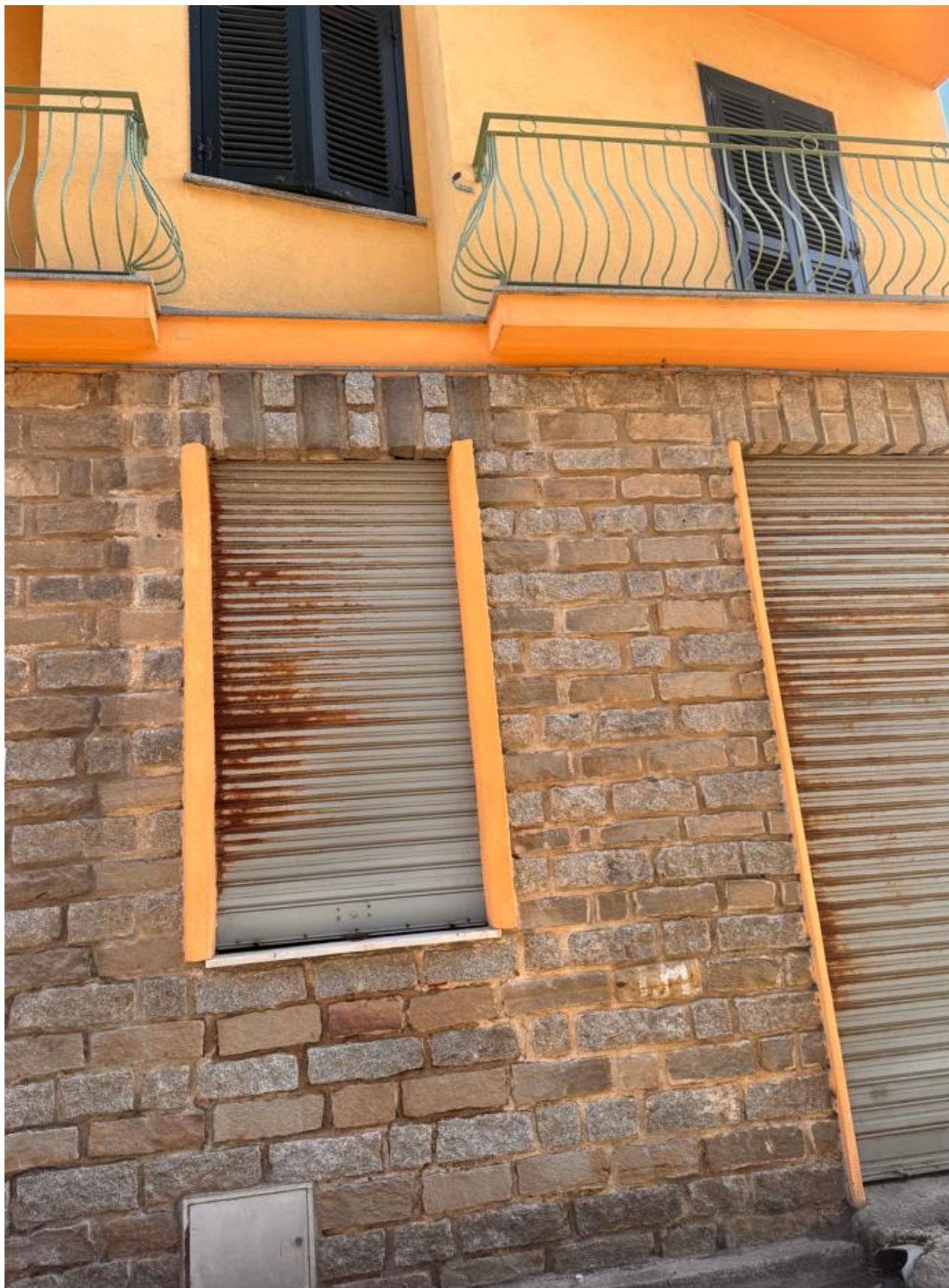
Foto 26: Vista esterna del garage a Piano Terra e dell'appartamento al Piano Primo
