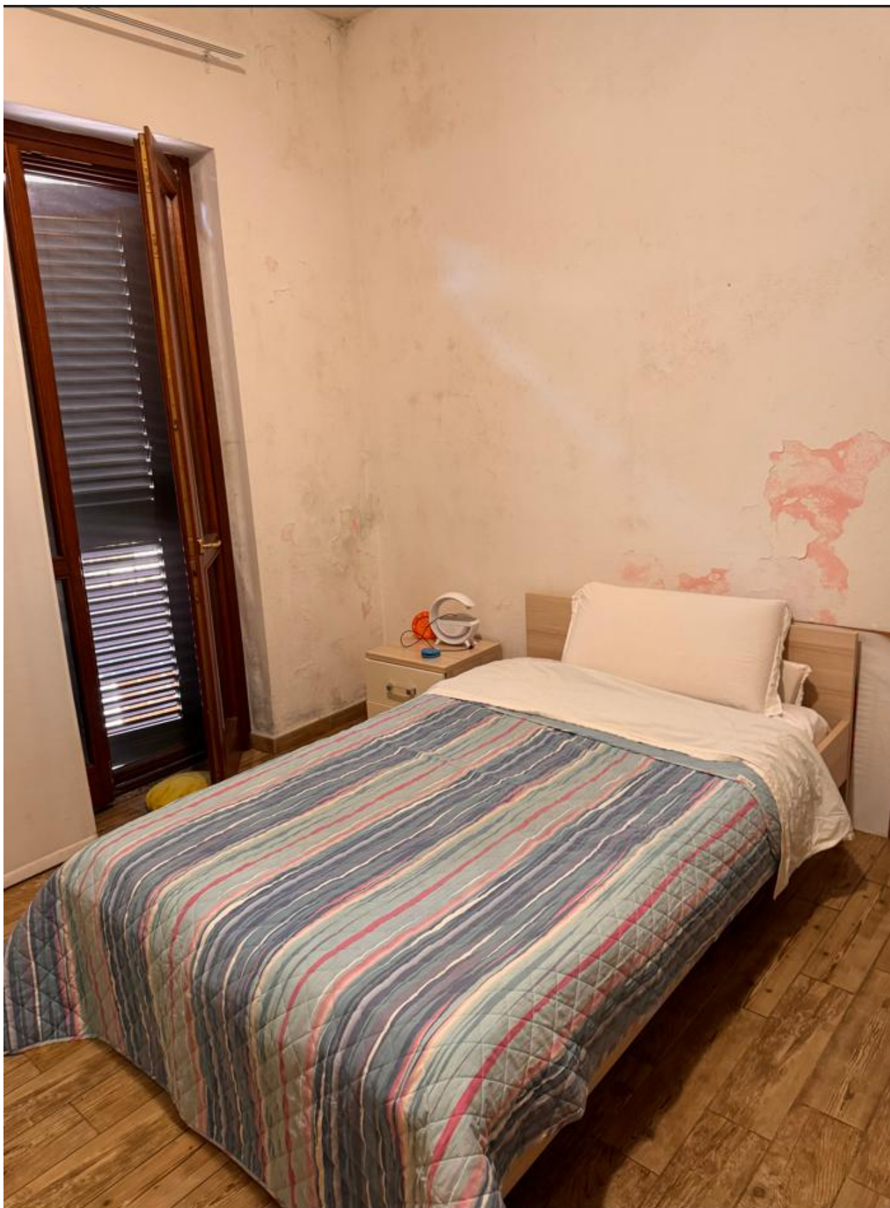
Foto 13: Letto e porta di accesso al balcone
